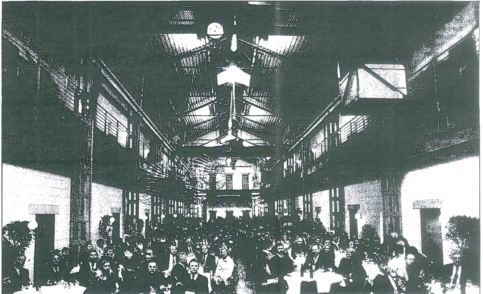
Für insgesamt etwa 20 Millionen Mark entstand aus einer Industrie-Ruine ein Gründerzentrum, in dem Jungunternehmer gute Startvoraussetzungen vorfinden. Die Beratungs- und Serviceangebote der Innovationsfabrik sind auf sie speziell zugeschnitten worden. (Foto: Monika Scheffler)
